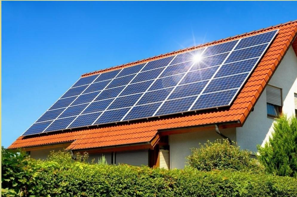
Il rendimento del pannello ovviamente diminuisce con l'età e con la polvere, dipende dall'orientazione Est-Sud-Ovest del tetto, e dall'inclinazione del pannello rispetto ai raggi solari.
