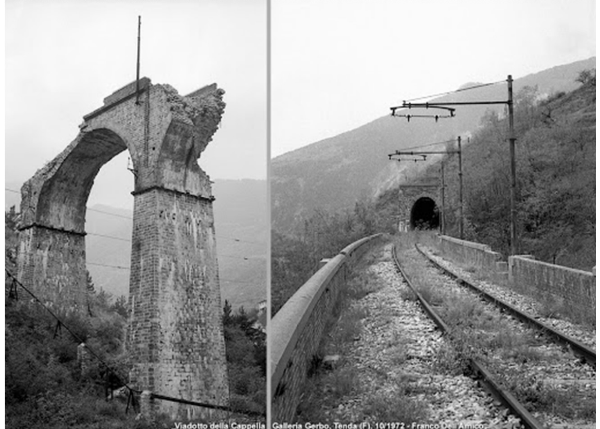
Viadotto della Cappella Galleria Gerbo, Tenda (F), 10/1972 - Franco Dell'Amico
