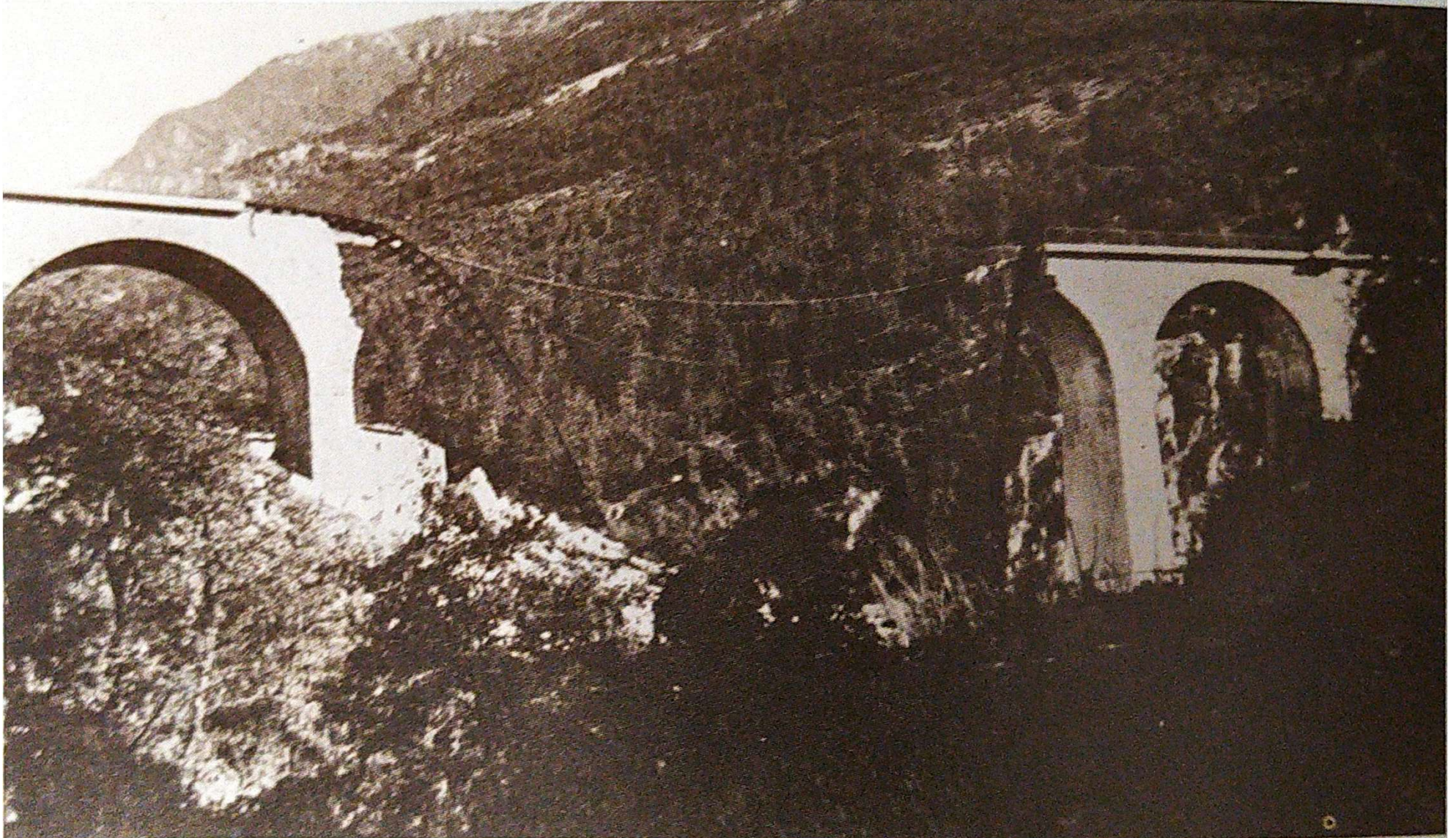
Il viadotto della Basséra, tra Breil e Sospel, era già stato abbattuto alla mezzanotte del 10 giugno.
