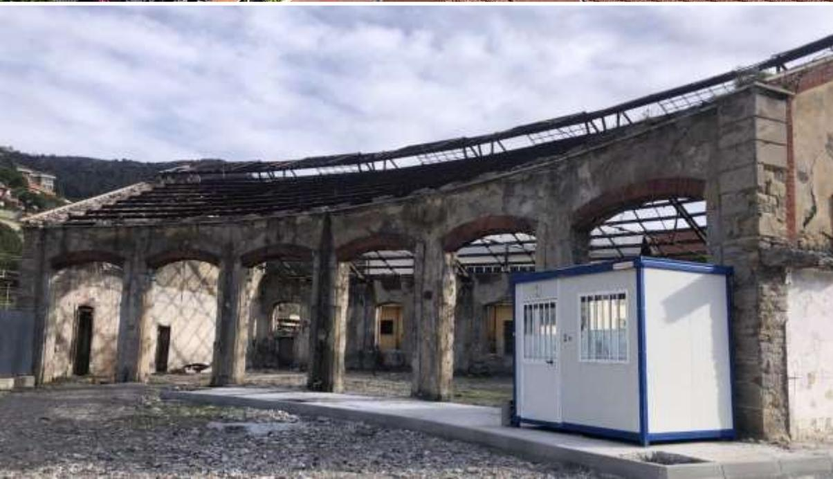
Il Deposito Locomotive di Ventimiglia è stato realizzato alla fine del XIX secolo secondo un progetto standard comune ad altri impianti della SNCF, con la struttura in ferro della copertura progettata da *Gustav Eiffel*. L'edificio, oggi abbandonato e fatiscente, sarà ristrutturato ed adibito a Casa di Comunità.
