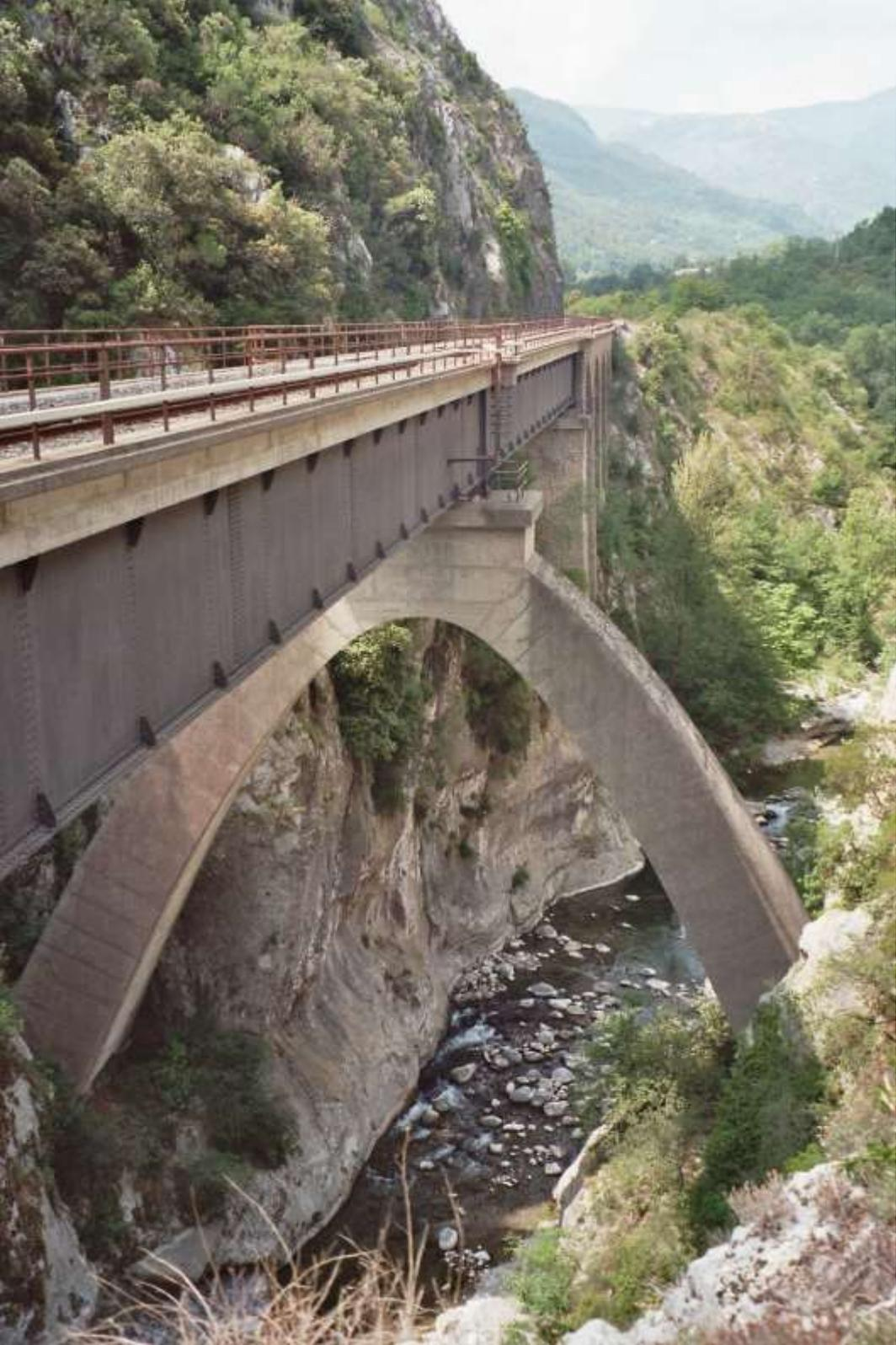
Dopo la guerra, il viadotto è stato ricostruito in calcestruzzo armato seguendo il progetto originale, che era però stato realizzato in pietra da taglio. L'impalcato è ora costituito da una struttura metallica scatolata. Per le sue peculiarità, è una delle opere d'arte che caratterizzano la linea. Complessivamente, il viadotto supera i 90 m.
