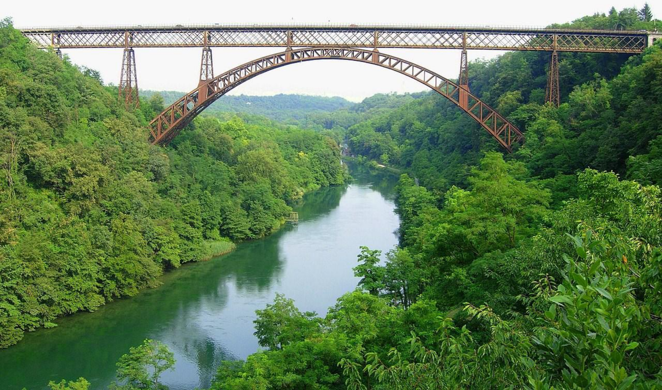
Il ponte di Paderno sull'Adda, a traffico misto stradale e ferroviario, lungo 266 metri. La struttura ad archi parabolici interamente chiodata è tra le più rilevanti realizzazioni del tempo. 1889.
