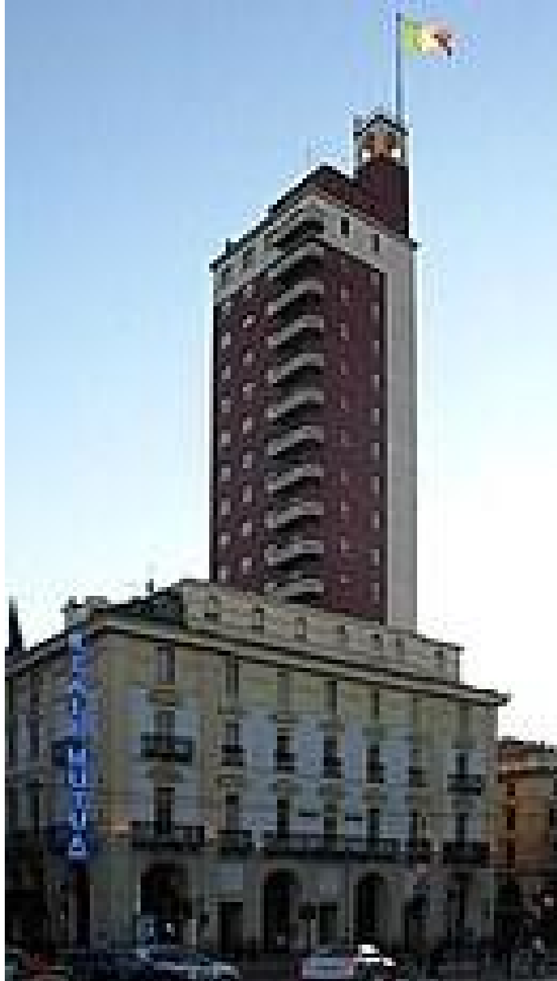
Il Grattacielo Reale Mutua di piazza Castello, il primo grattacielo italiano con struttura metallica elettrosaldata, 1933.
