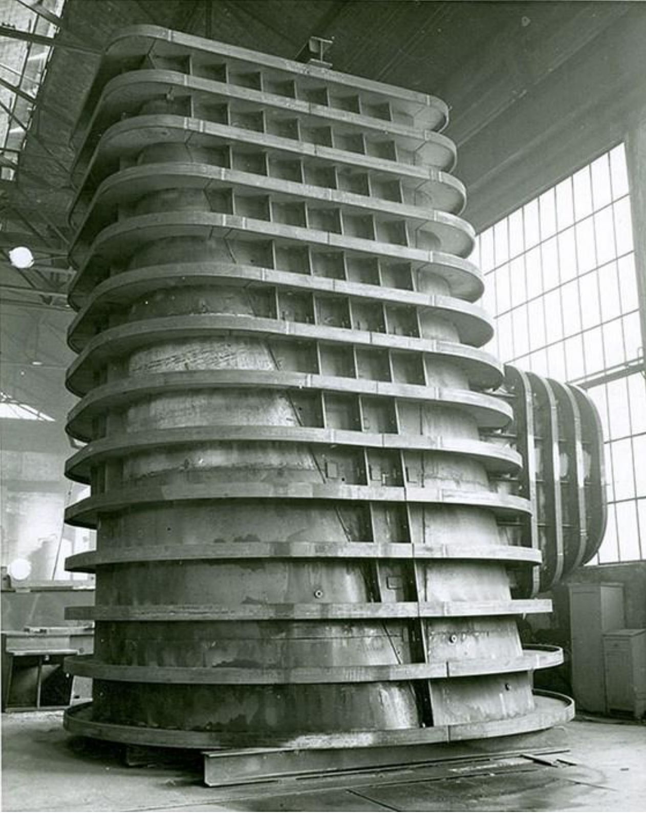
Interni delle Officine di Savigliano: rivestimento di una galleria per una condotta forzata, ca. 1965.
