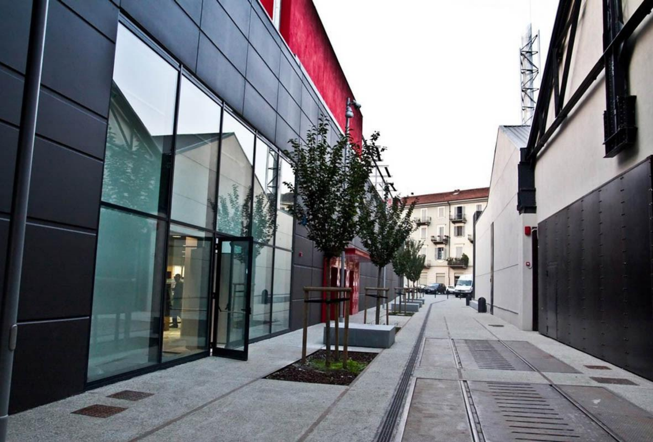
I vecchi binari interni allo stabilimento sono stati conservati nella riqualificazione del complesso, 2009.
