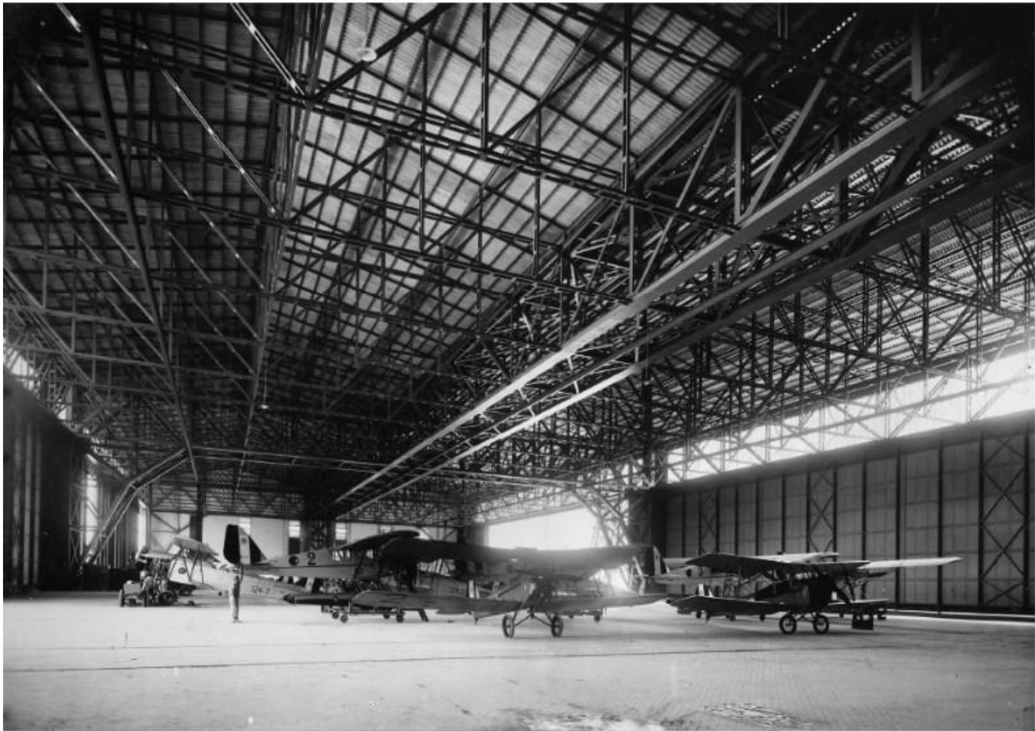
Hangar per l'aeroporto militare di Elmas, Cagliari, in cui è stata usata l'innovativa tecnologia della elettrosaldatura dei componenti (135x55 metri, la più grande struttura saldata in Europa). 1933.
