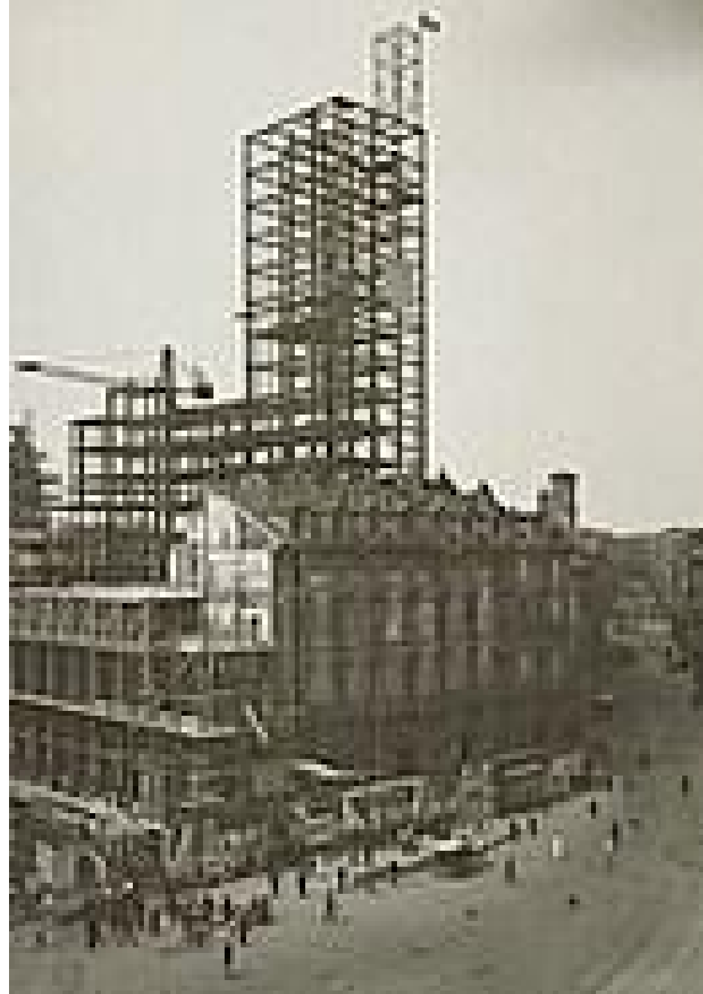
Il Grattacielo Reale Mutua di piazza Castello, il primo grattacielo italiano con struttura metallica elettrosaldata, 1933.
