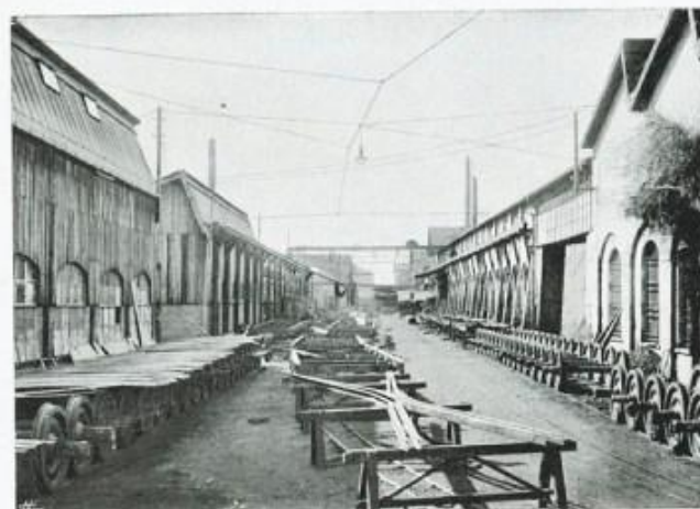
Officine di Savigliano - Deposito assi e montaggio telai. 7012
