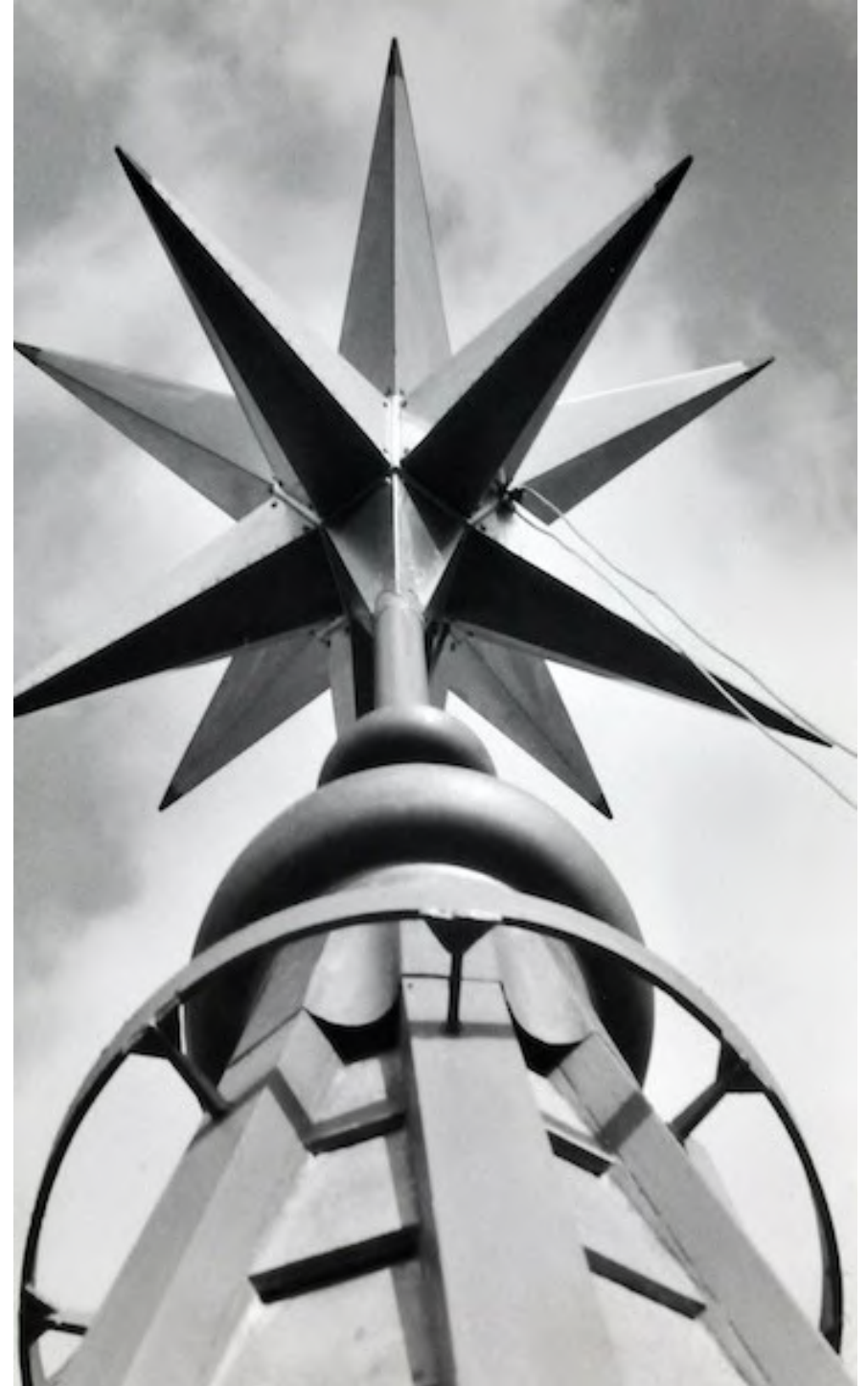
Ricostruzione in struttura d'acciaio rivestita di pietra dei 47 metri della guglia della Mole Antonelliana crollata per il nubifragio del 1953. Compresa la realizzazione della stella in acciaio inox. 1961.
