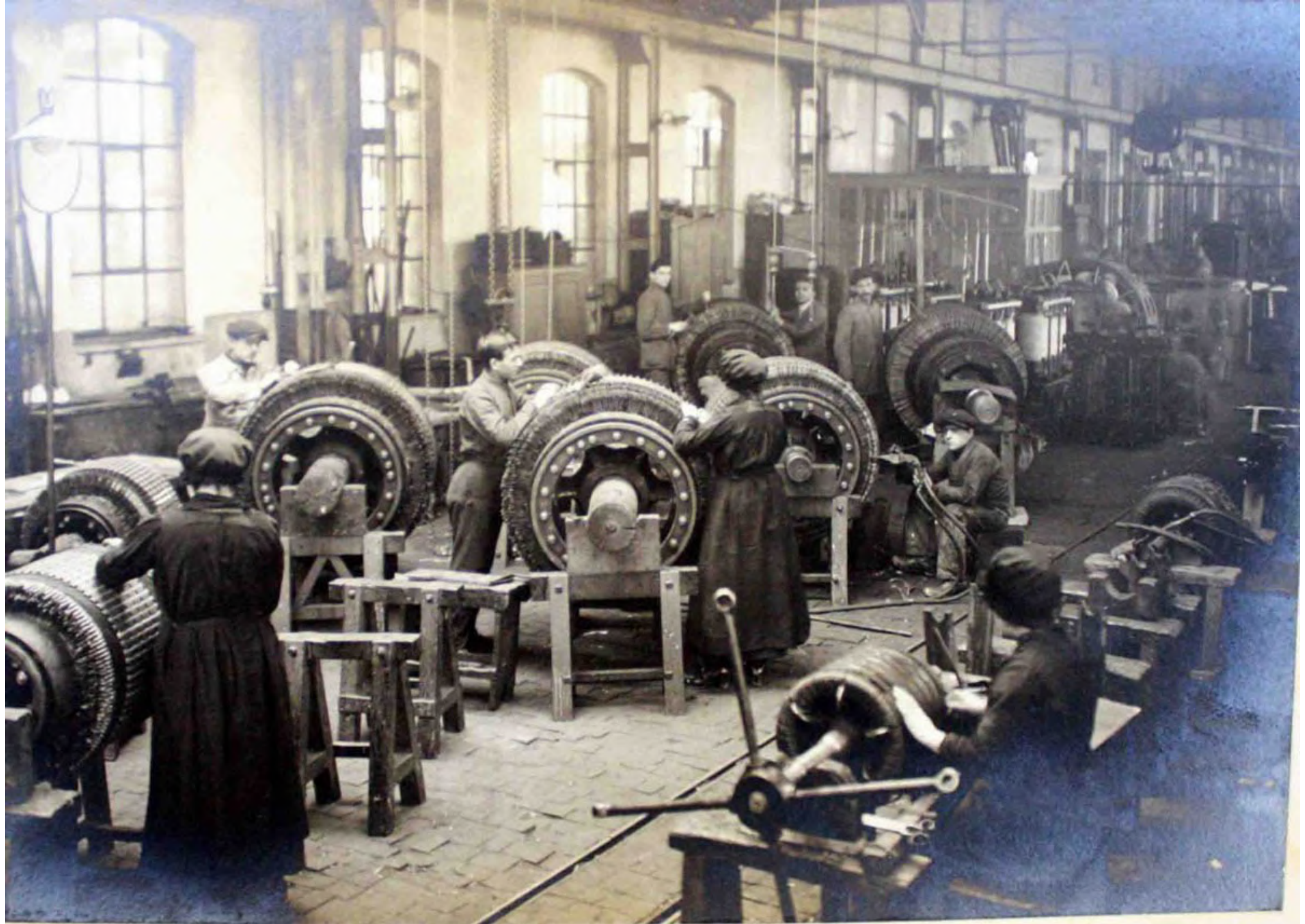
Elettricità, montaggio degli avvolgimenti per motori a corrente continua per sommergibili, 1915-16.
