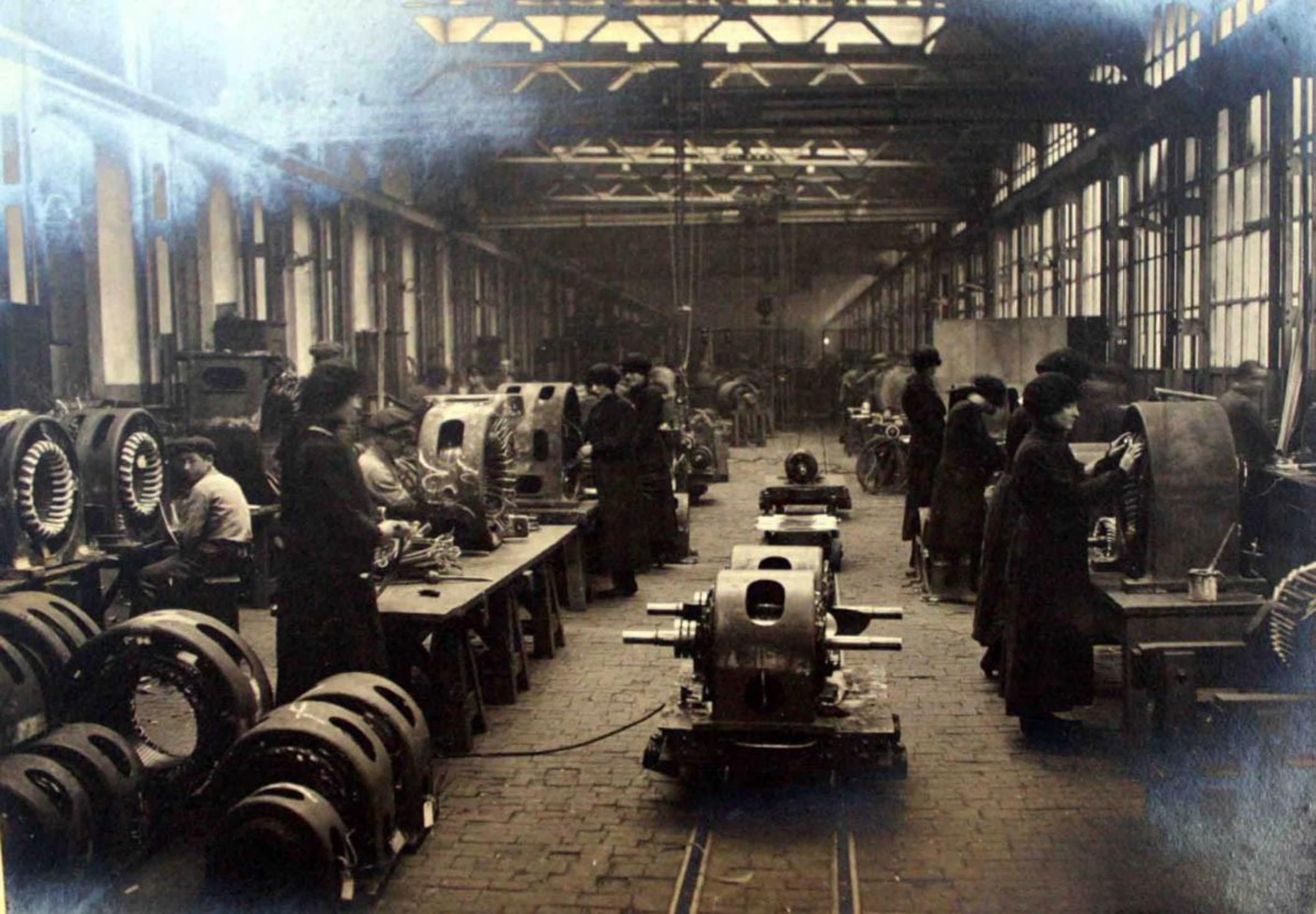
Elettricità, montaggio degli avvolgimenti degli statori dei motori trifase, 1915-16.
