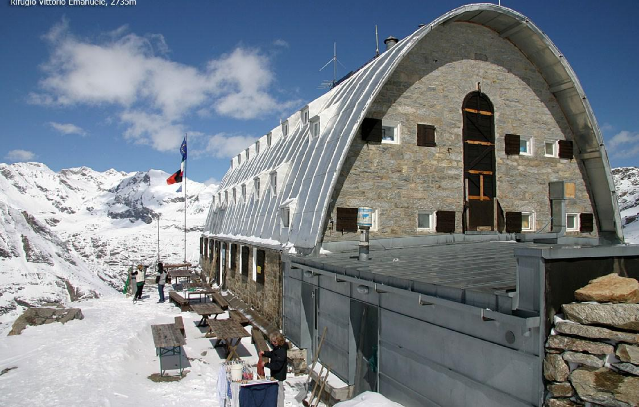
La particolare conformazione del rifugio Vittorio Emanuele II sul Gran Paradiso, rivestito in alluminio. La struttura è terminata nel 1934, ma diverse vicissitudini portano ad inaugurare il rifugio solo nel 1961.
