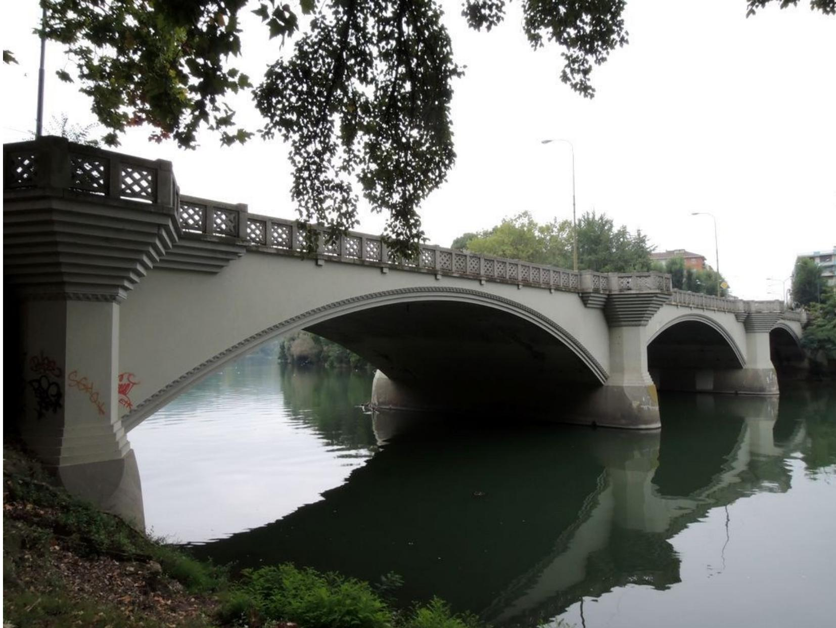
Le tre campate sono realizzate con profilo parabolico. Anche in questo punto, prima del ponte, era in opera un traghetto che univa le sponde del fiume.
