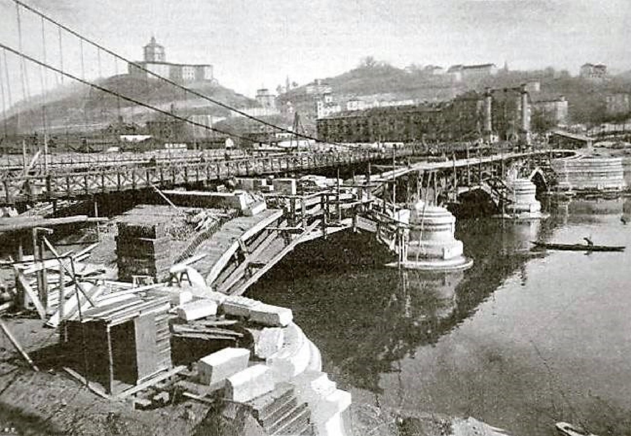
Un'immagine del ponte in costruzione, prima dell'abbattimento del ponte di ferro. Il nuovo ponte, lungo 124 metri e largo 23, con tre archi a sezione policentrica, è stato realizzato dall'impresa Allegri, Lazzari & C. per l'importo forfettario di 1.690.000 lire.
