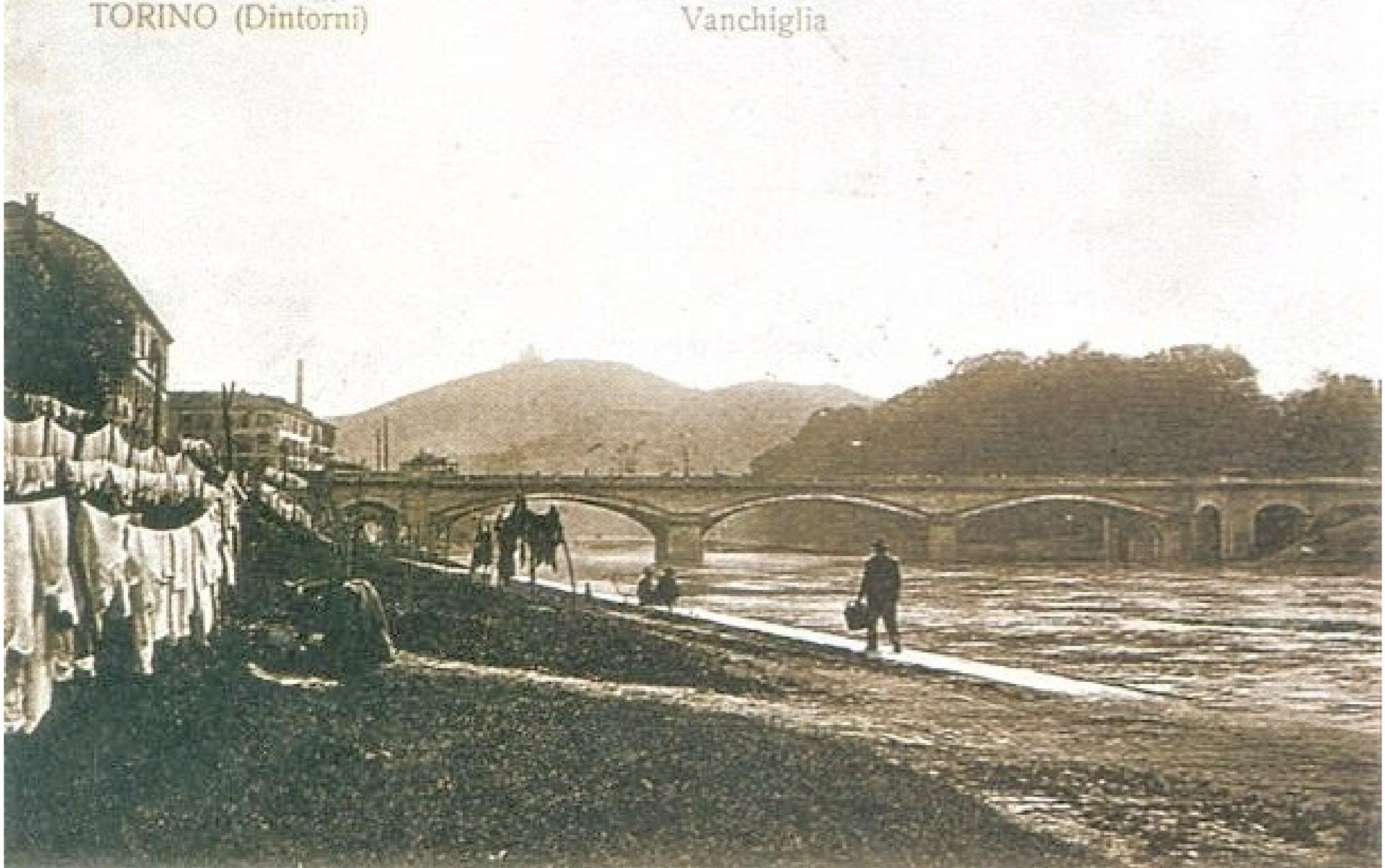
Il ponte viene concluso nel 1882, a tre campate ad arco ellittico ribassato, con caratteristiche strutturali che ricordano quelle del Ponte Isabella. La struttura, in muratura, era larga 12 metri ed aveva nelle spalle due arcate che permettevano il passaggio da un lato del transito pedonale e dall'altra del canale Michelotti.
