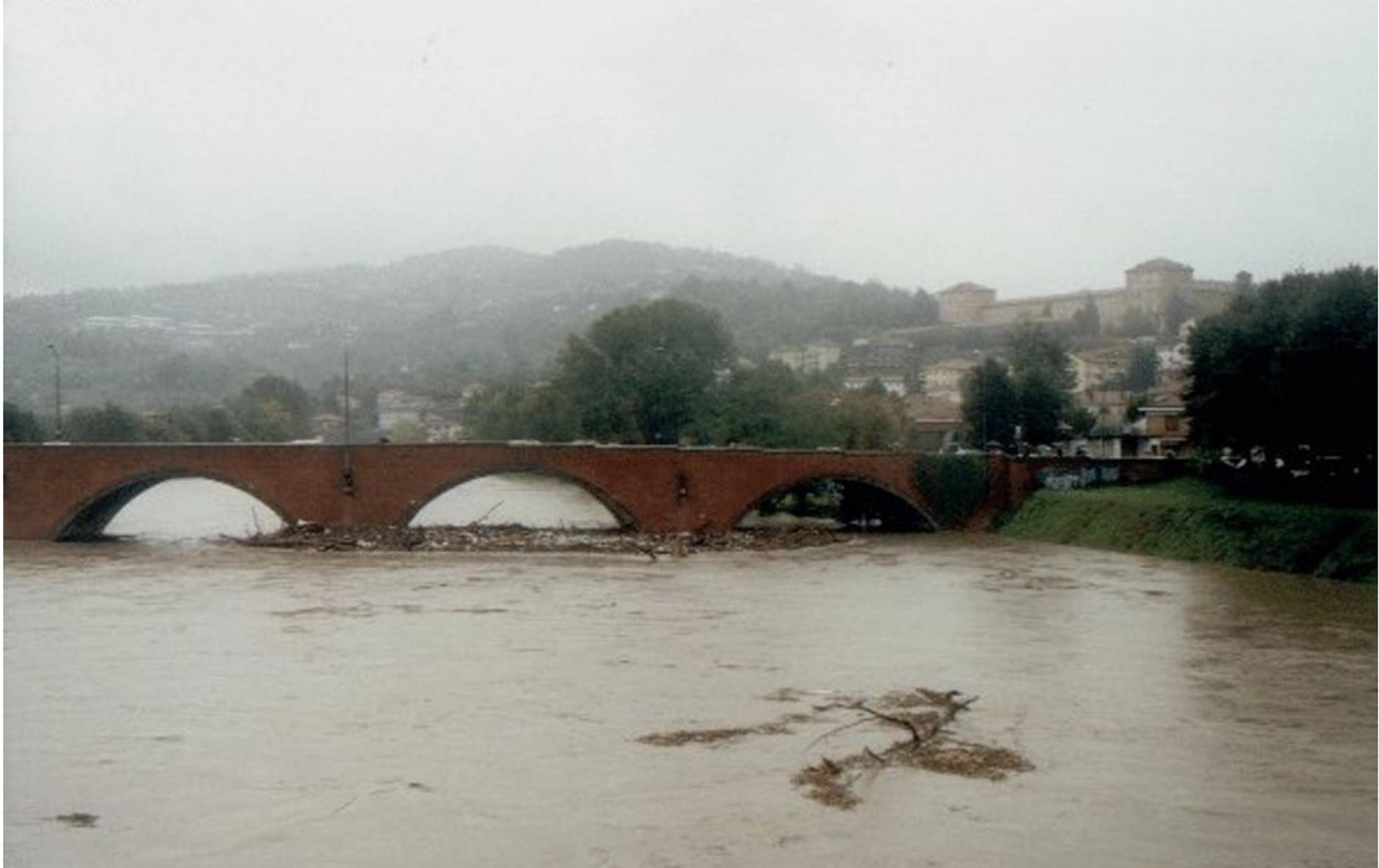
Il ponte dei Templari durante l'alluvione del 2016. La confluenza del Chisola ed il basso livello della pianura circostante provocano spesso disastrose alluvioni. Anche la massiccia struttura a 5 arcate a tutto sesto contribuisce ad ostacolare il passaggio dell'acqua.
