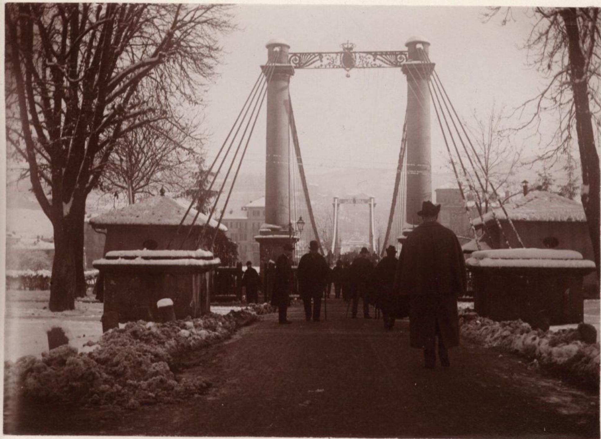
Sempre di Gabinio, questa immagine invernale evidenzia la struttura dei portali e degli ancoraggi delle funi portanti. Sono anche visibili i chioschi per l'esazione del pedaggio: 5 centesimi per un pedone, 40 per una vettura a 2 cavalli.
