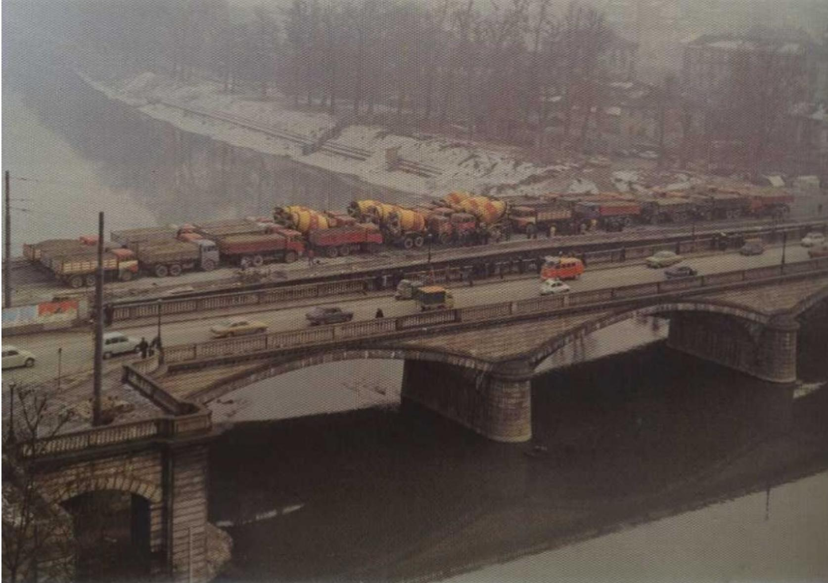
Il nuovo ponte è stato realizzato in due fasi, per consentire comunque il transito. Dopo il collaudo (nella foto) e l'apertura al traffico della prima metà, si è proceduto a demolire il vecchio ponte e costruire la seconda metà, raggiungendo la larghezza complessiva di 35,50 metri.
