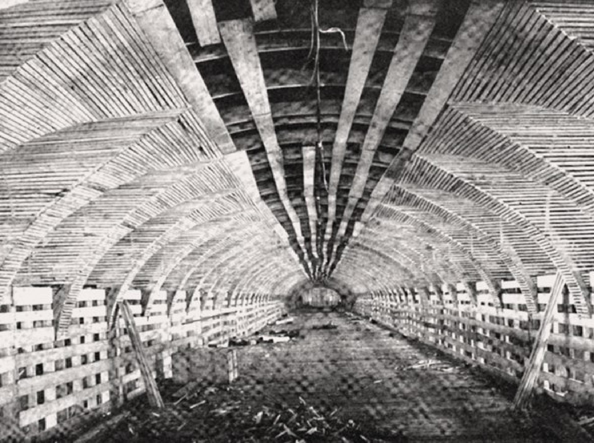
Lungo tutto lo sviluppo del ponte correva una galleria di collegamento fra le due rive del fiume. La galleria era divisa in tre tunnel paralleli: quello centrale ospitava un *tapis roulant*, quelli laterali permettevano di camminare ammirando la vista del fiume attraverso una lunga serie di finestre a lunetta. Questa è l'unica immagine nota della galleria, ancora in costruzione.
