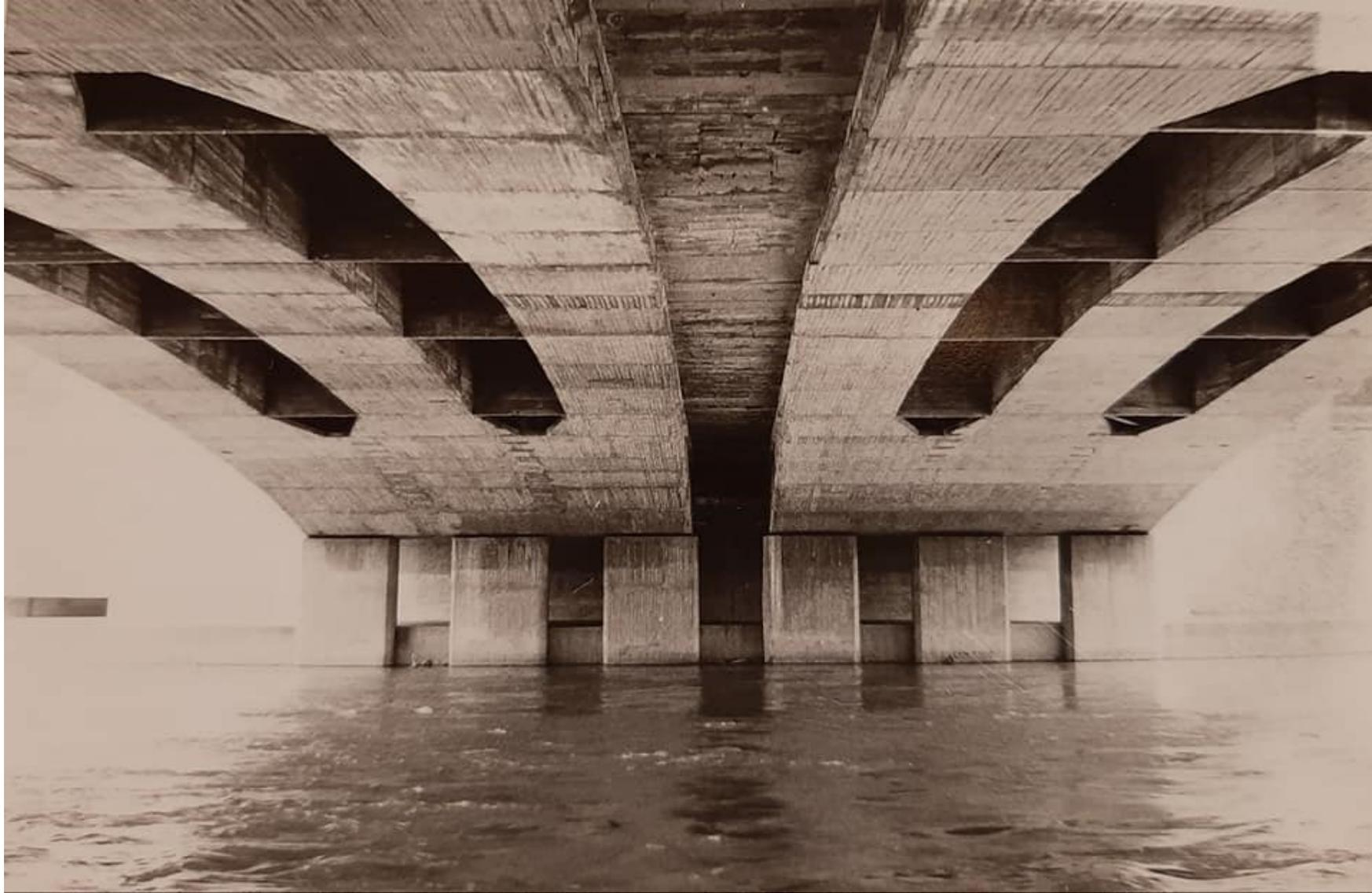
Il nuovo ponte è stato realizzato in cemento armato precompresso su 4 appoggi, realizzato a sbalzi successivi con luce massima di 90 m. e ancorato agli appoggi esterni con tiranti profondi, realizzando una concezione strutturale del tutto innovativa. Le campate laterali sono zavorrate con tiranti ancorati alla roccia per contrappesare la campata centrale.
