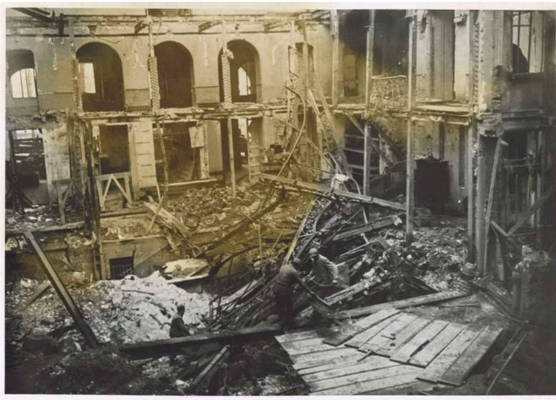
Gli effetti dei bombardamenti del 26 novembre 1942 sulle strutture dell'Hotel Ligure et d'Angleterre.
