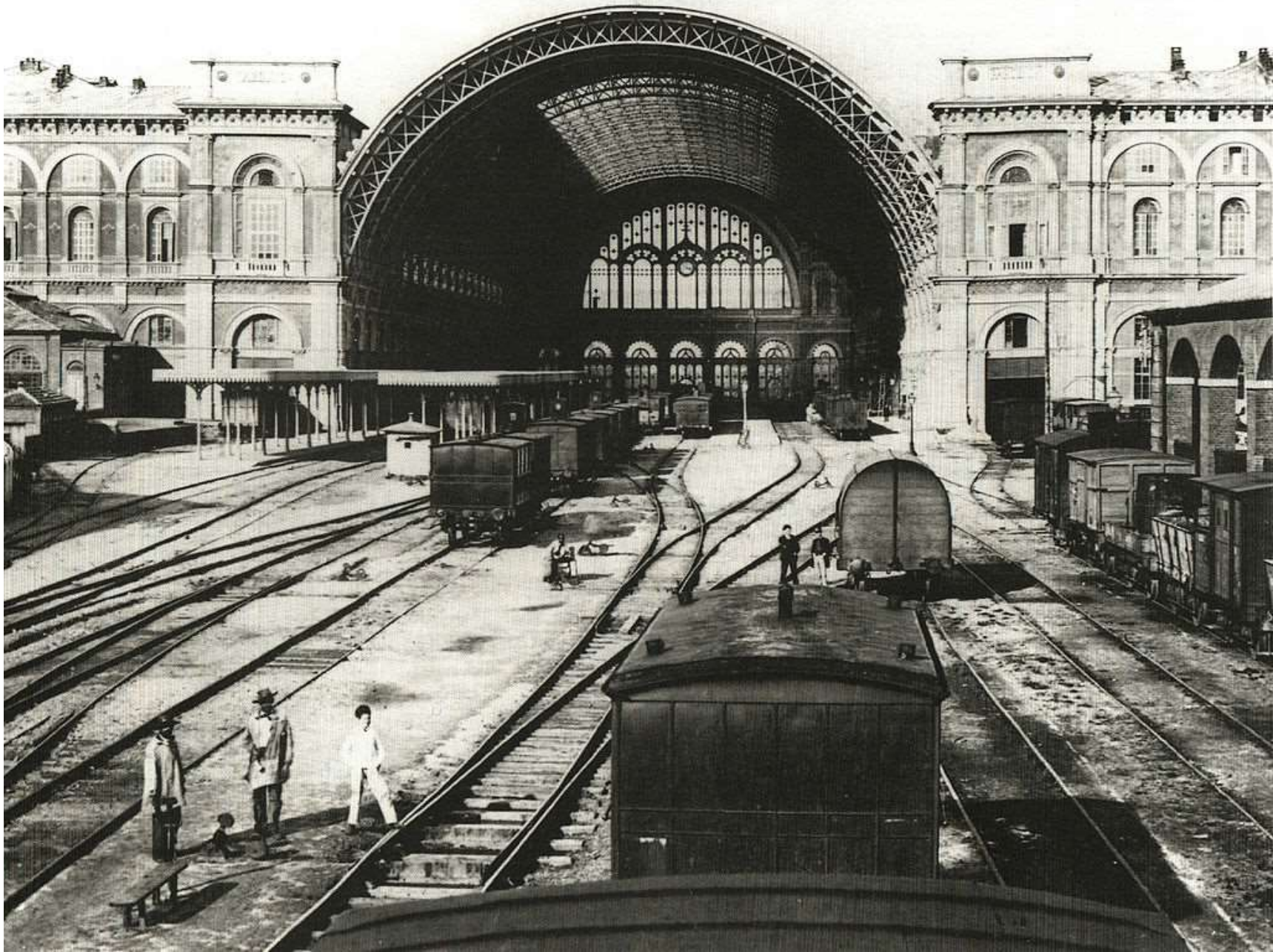
Il fabbricato viaggiatori della stazione di Porta Nuova visto dal lato dei binari nel 1884. I treni giungono fino all'attuale atrio. Nel 1906 vengono aggiunti 12 binari che si attestano all'esterno dell'edificio e vengono anche arretrati i 7 binari originari.
