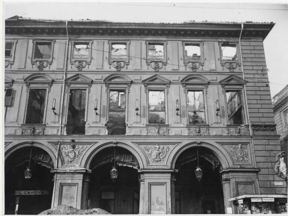
Verso il 1760 le colonne del porticato diedero segni di cedimento e dovettero essere inglobate in massicci pilastri.
