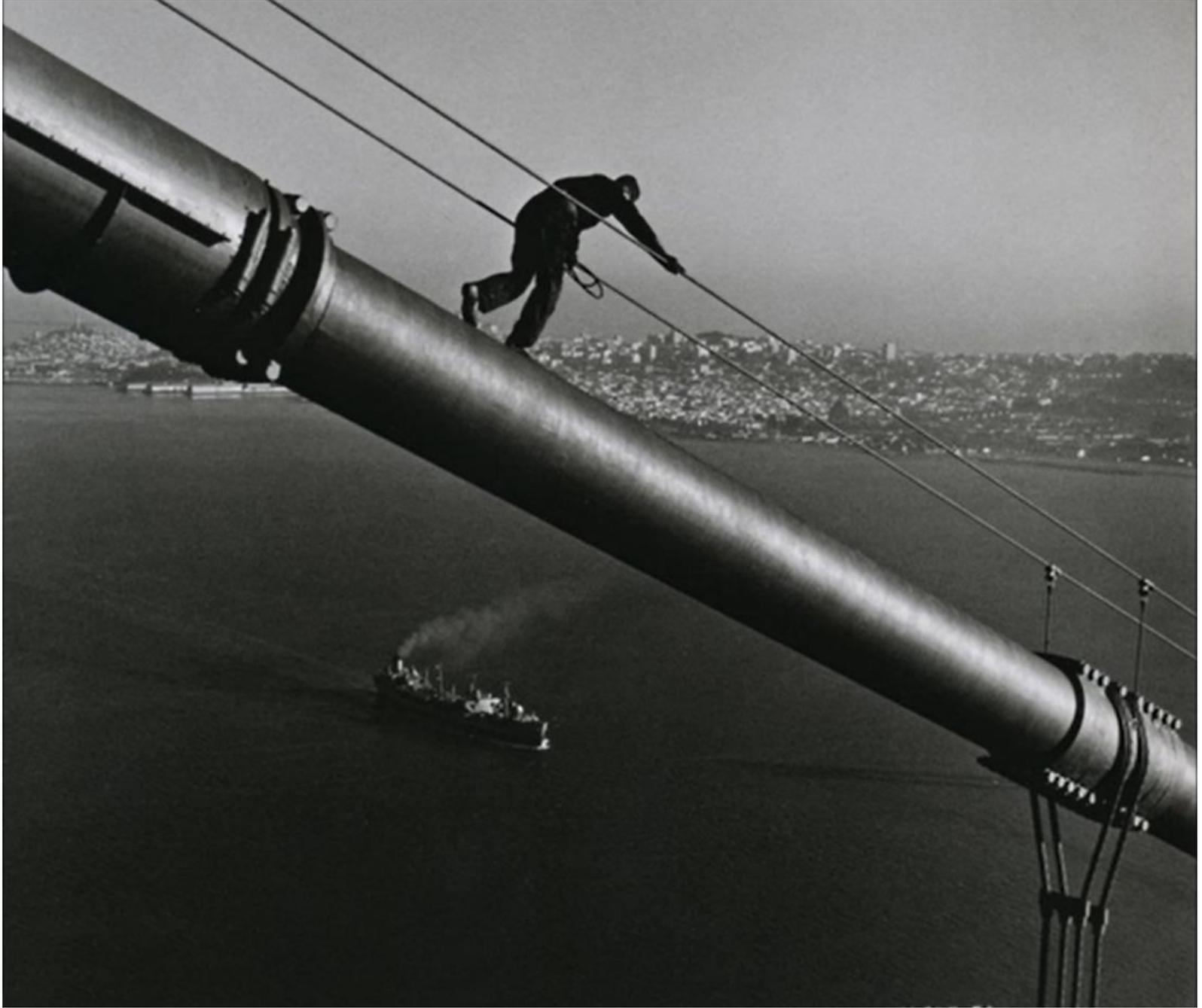
1947. Un addetto alla manutenzione scende lungo il cavo di sostegno del Golden Gate a San Francisco.
