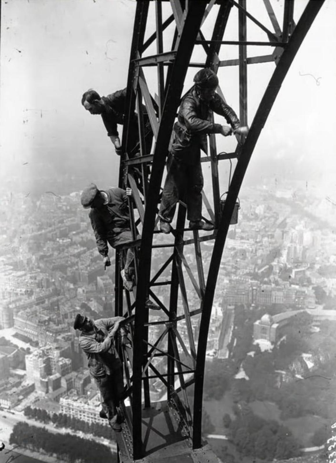
1932. Un gruppo di operai procede alla riverniciatura della Torre Eiffel. I 200.000 metri quadri di superficie della torre vengono riverniciati ogni sette anni, per un totale di 60 tonnellate di vernice applicate in un intervento della durata di 16 mesi.
