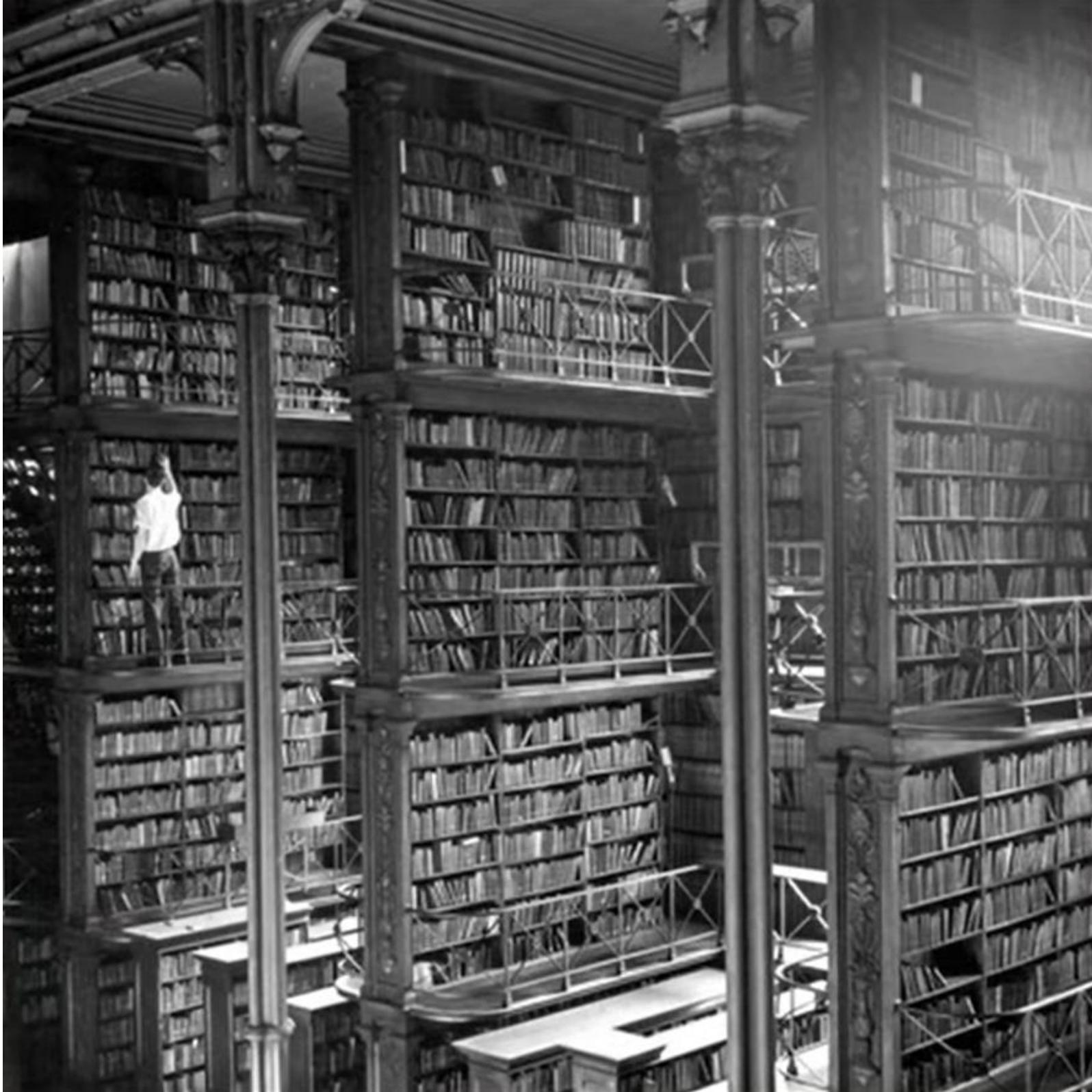
1950. La vecchia Biblioteca Pubblica di Cincinnati, Ohio. Una colossale struttura multipiano di ghisa, raccordata da scale a chiocciola. Realizzata nel 1897, viene sostituita dal nuovo edificio nel 1991.
