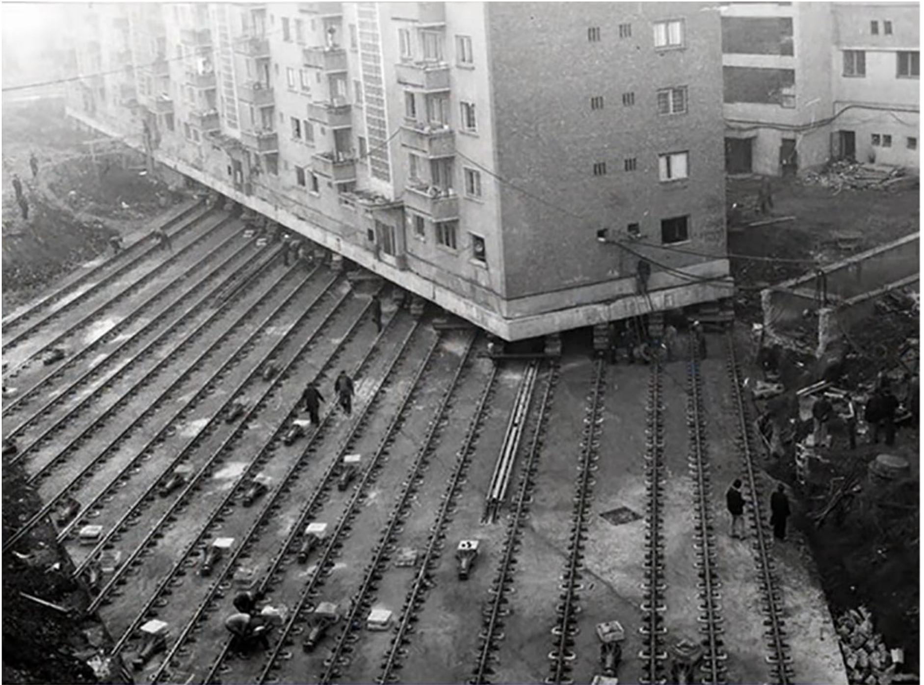
27 maggio 1987. Ad Alba Iulia, Romania, si sposta un intero edificio lungo 110 m e pesante 7600 t per far posto ad un grande viale. Diviso in due parti, una metà da 55 m è stata spostata su una serie di rotaie tramite martinetti idraulici in circa 6 ore.
