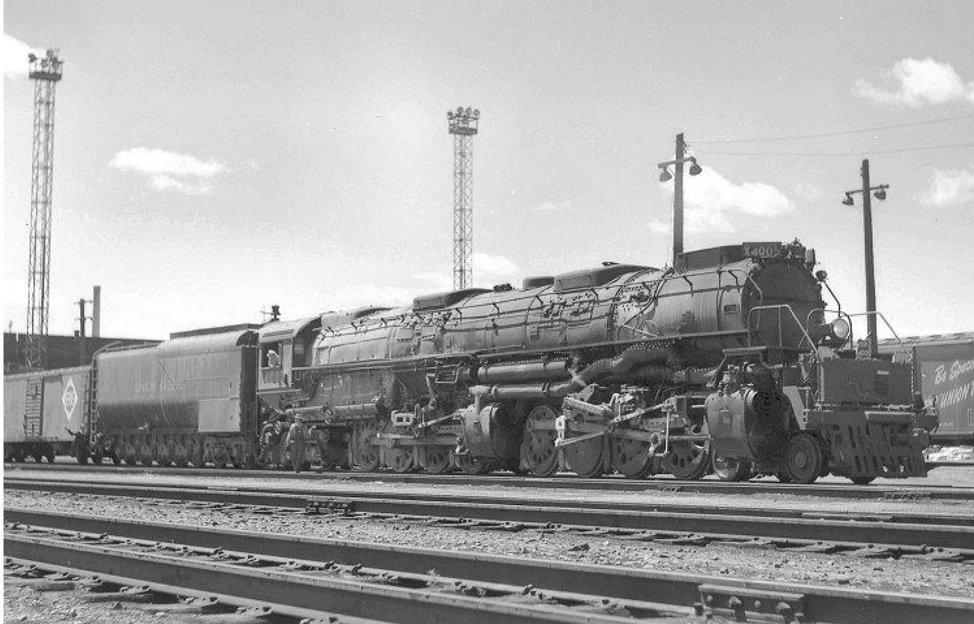
1957. Big Boy. Questo gruppo di locomotive nasce tra il 1941 e il 1944 in seguito alla esigenza della Union Pacific Railroad di avere un rotabile in grado di evitare l'uso della doppia trazione lungo le linee accidentate delle Wasatch Mountains tra lo Utah e lo Wyoming. Con una potenza di 4.700 kW sviluppata nonostante l'uso di carbone di qualità scadente, le locomotive sono articolate combinando due meccanismi motori.
