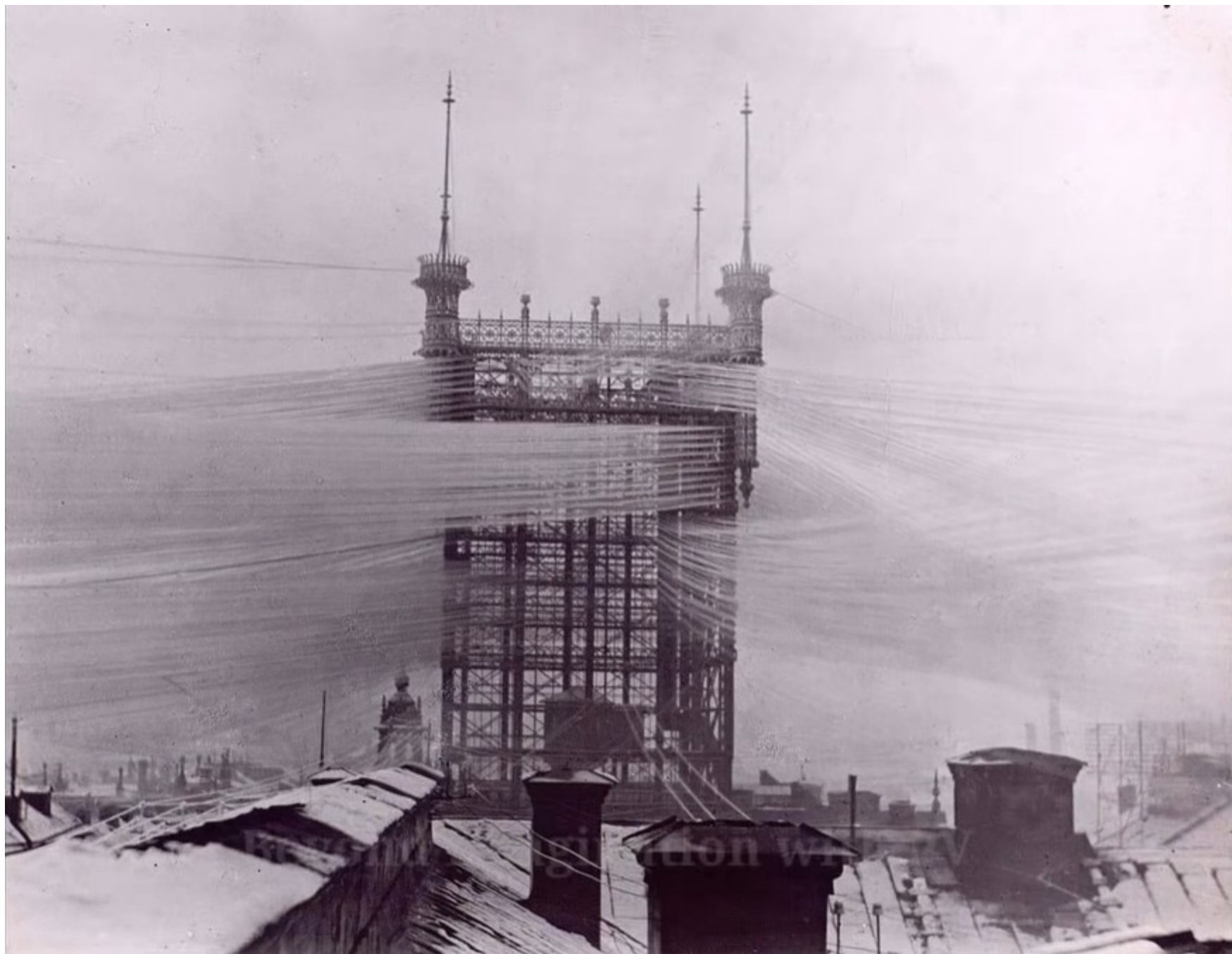
1890. La torre dei telefoni di Stoccolma, con circa 5500 linee collegate, alta 80 metri. Inutilizzata dal 1913, è stata demolita nel 1953.
