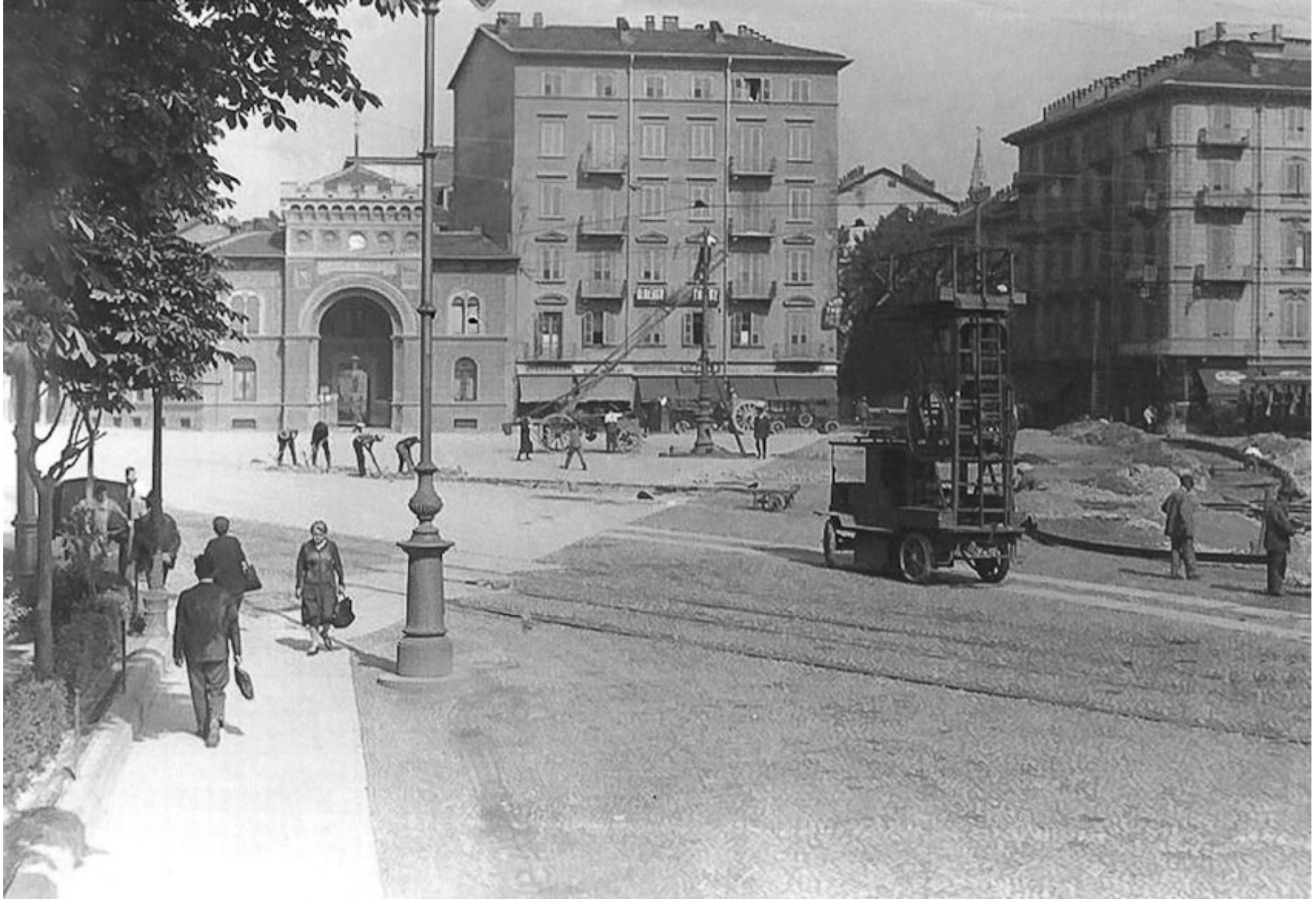
Anni '30. Lavori per la viabilità. Il lavoro manuale è integrato da una scala Porta e da un trabattello ad accumulatori per la rete aerea tranviaria. Il palazzo all'angolo è stato sopraelevato di 2 piani nel dopoguerra.
