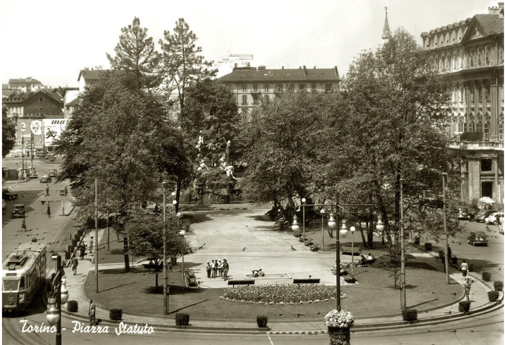
1958. È già stata demolita la stazione della Torino-Rivoli e sta iniziando la costruzione della torre BBPR. Sulla recinzione la pubblicità Marus.
