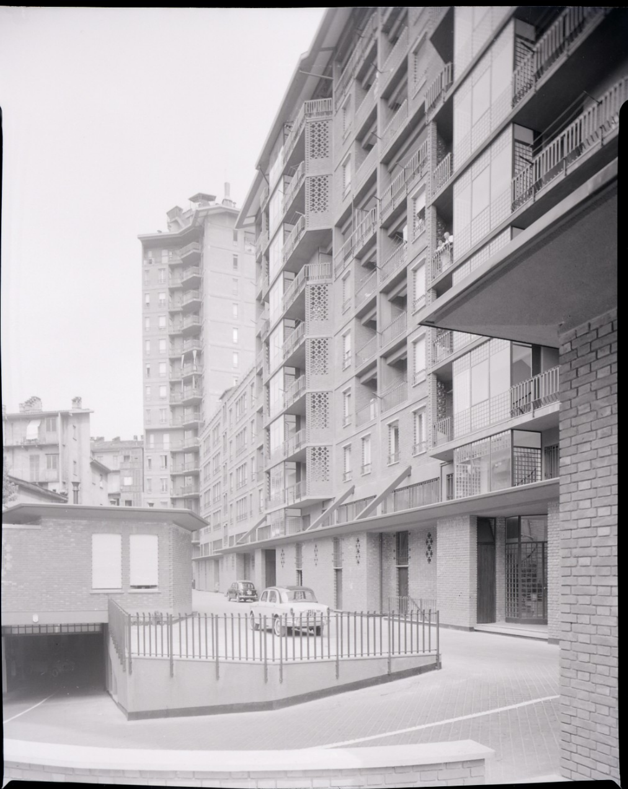
Un'immagine scattata nel 1970 del lato interno del complesso BBPR.
