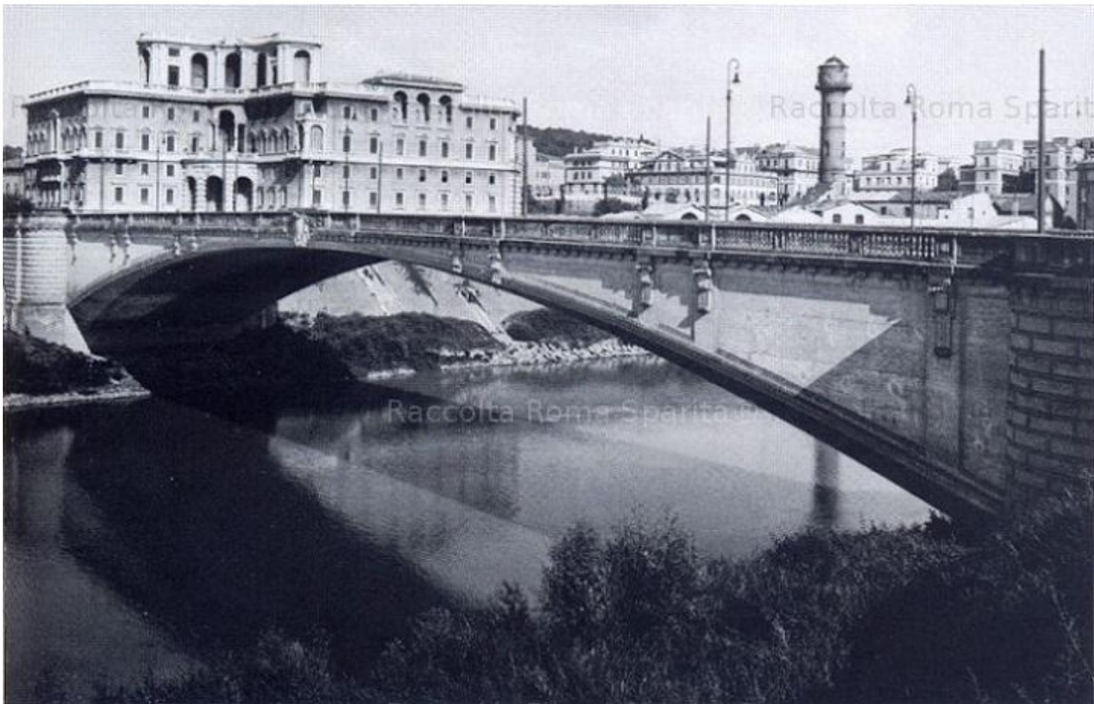
Il capolavoro di Porcheddu è considerato il *Ponte Risorgimento* sul Tevere a Roma, realizzato nel 1911 in occasione dei festeggiamenti del Cinquantenario dell'Unità d'Italia; l'opera, consistente in una sola arcata di 100 metri di corda e 10 metri di freccia, di arditissima concezione, fu completata in soli sedici mesi di lavoro.
