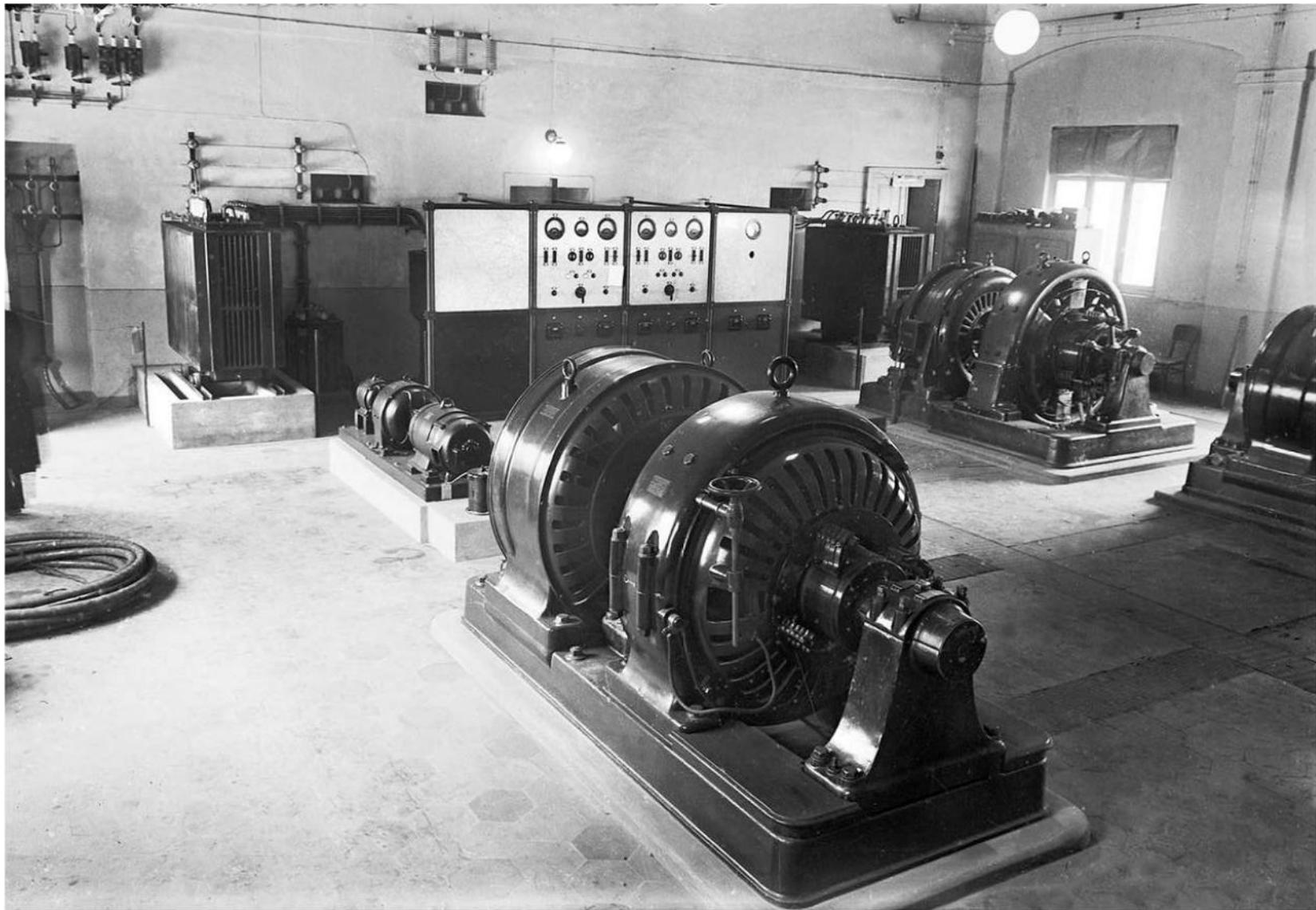
Nel vecchio fabbricato delle macchine a vapore vengono installati i nuovi gruppi di trasformazione e conversione. Si vedono i quadri di comando con gli strumenti incastonati in lastre di marmo. In seguito i gruppi rotanti verranno sostituiti con raddrizzatori a vapori di mercurio.
