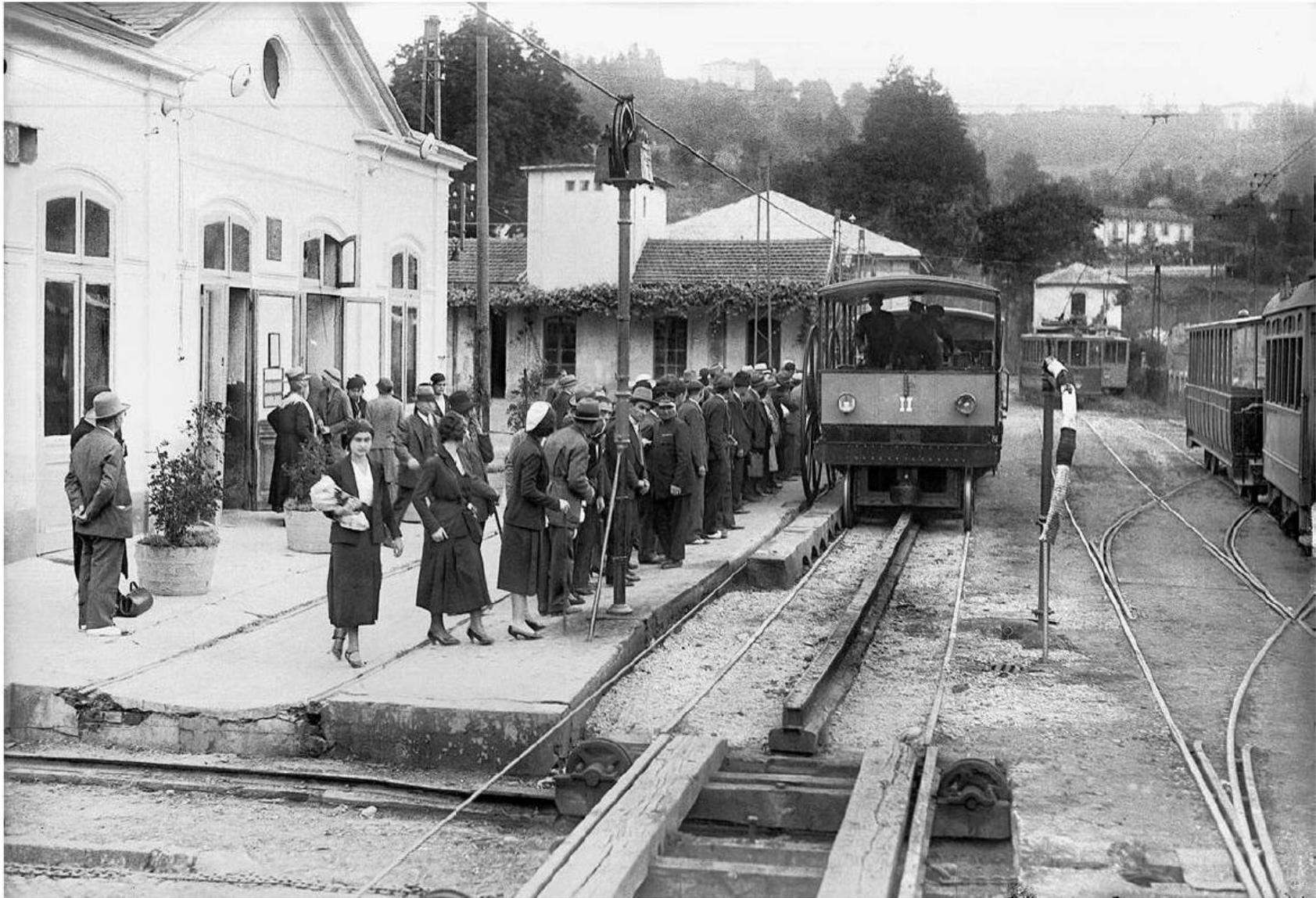
Sul piazzale di Sassi i convogli venivano composti e scomposti utilizzando vecchi tram come locomotori, ma anche con l'ausilio di un carro trasbordatore parallelo a corso Casale.
